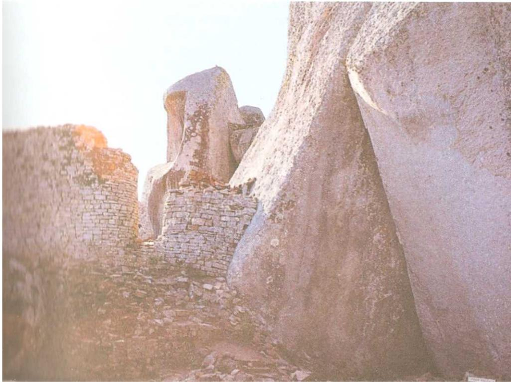
*Проемы в скалах Акрополя искусно заделаны камнями. Самая толстая из этих стен имеет ширину 6,7 метра.*
